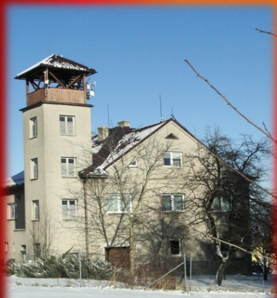
Pohled na hasičskou zbrojnici
